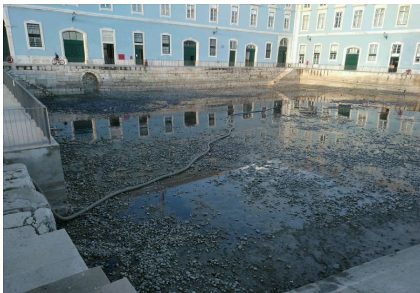
Figura 12 - Trabalhos de limpeza e desassoreamento na Doca da Caldeirinha (“Operação de Limpeza Da Doca Da Caldeirinha, Ribeira Das Naus - MUNICÍPIO de LISBOA” n.d.).
