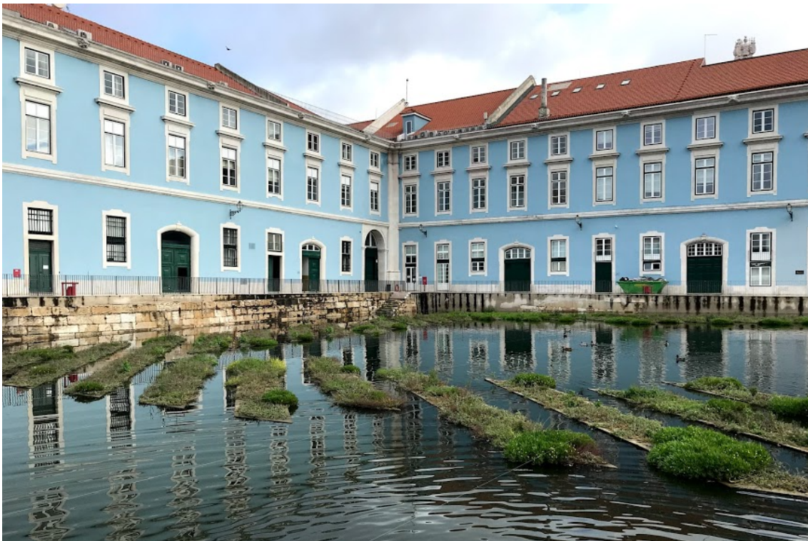
Figura 15 – Ilhas flutuantes instaladas na Doca da Caldeirinha (19/12/2020, 9 meses após a instalação).
